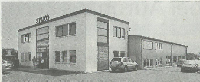
Das neue Stako-Firmengebäude gliedert sich in einen Bürotrakt (links), ein Zwischengeschoss (Mitte) und eine Produktionshalle.
